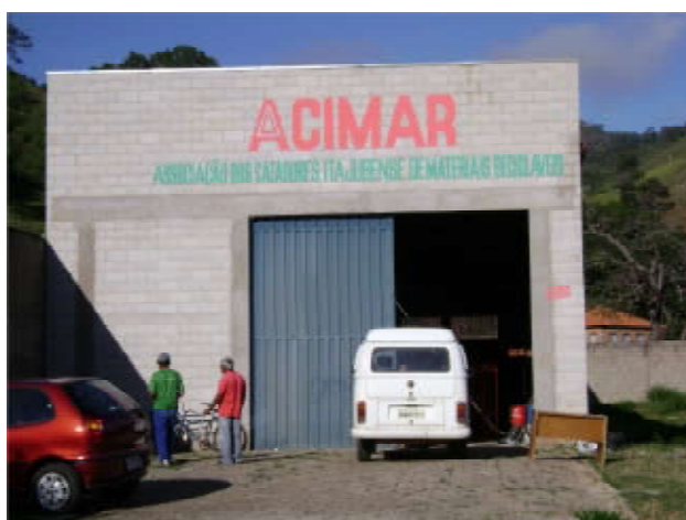
Galpão Subsidiado pela prefeitura.
